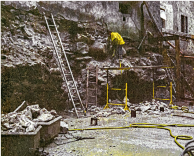
8: Warth-Weiningen TG, Kartause Ittingen. Dokumentation der Abbrucharbeiten im Bereich des Oberen Gästehauses, Ende 1970er-Jahre. Mehrere grosse Gerölle einer mittelalterlichen(?) Mauer sind erkennbar.
