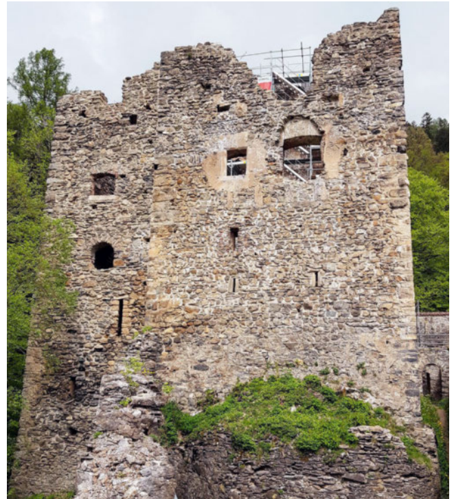
24: Dieselbe Ansicht nach der Konservierung, Unterfangung, Übermauerung sowie der Verstärkung des gefährdeten Fenstersturzes. Nach August 2017.
