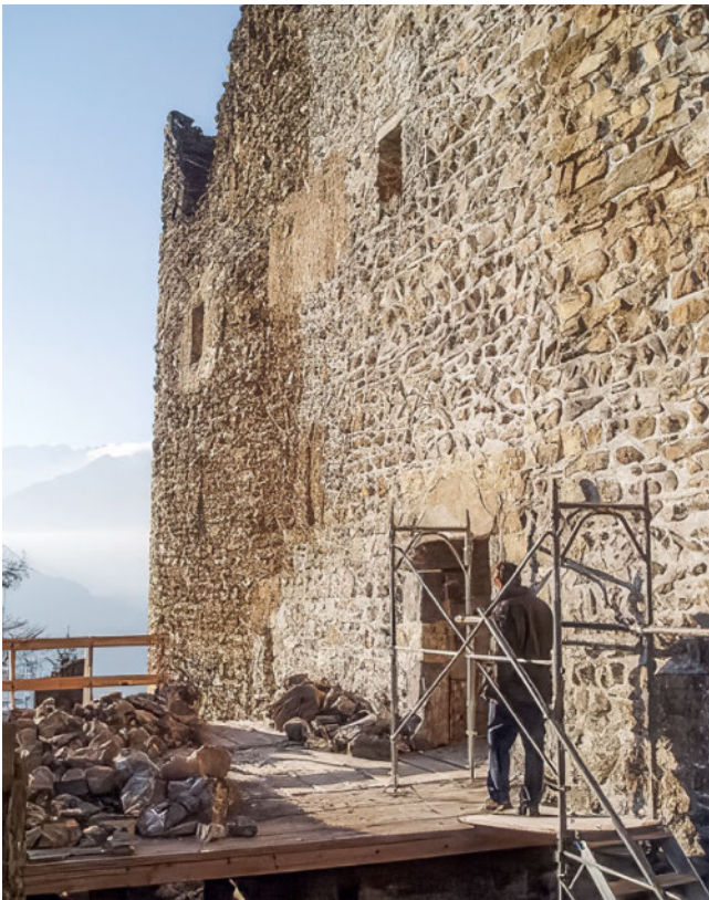
14: Teile der Südwand am Palas während der Sicherungsarbeiten, 2004.
