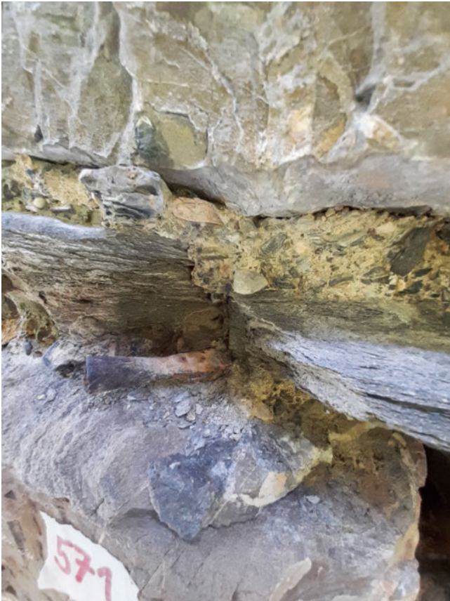
3: Armbrustbolzen im Mauerwerk des Wohnturms, 2021.
