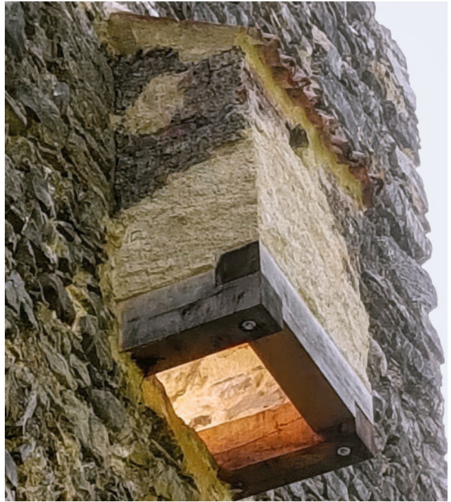
20: Dieser Abort-Erker konnte dergestalt rekonstruiert resp. wieder ergänzt werden, dass die Ablesbarkeit, was Bestand war und was neu hinzugefügt wurde, gewährleistet ist und zugleich die originalen Fragmente geschützt und erhalten werden. Nach August 2019.
