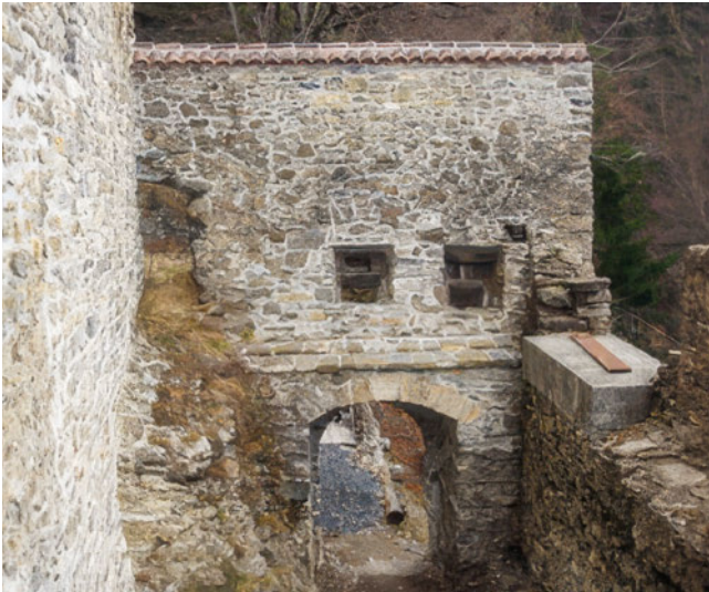
13: Eingangsbereich des Berings mit Torbogen nach der Sicherung, 2003.
