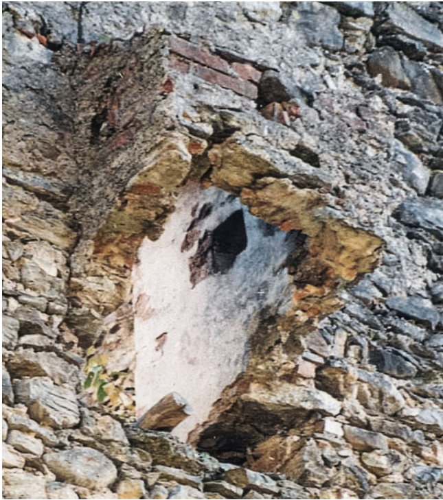
19: Auf der Nordseite des Anbaus waren noch Mauerfragmente eines typischen Abort-Erkers mit originalem Innenputz vorhanden. Vor August 2019.
