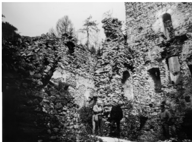
5: Blick auf die Mittelwand zwischen Palas und jüngerem Anbau sowie rechts der Turm mit Hocheingang, 1998.
