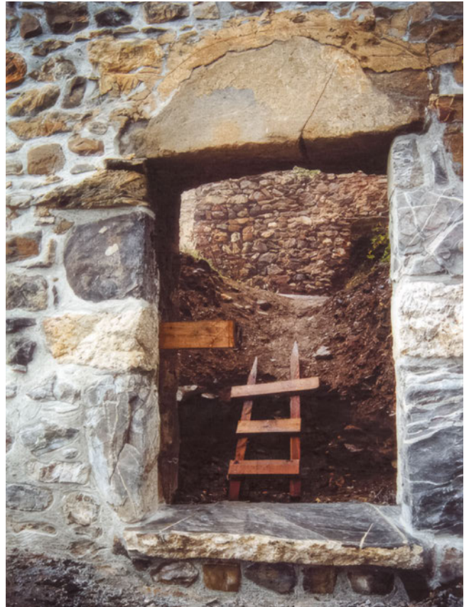
15: Haupteingang in den Südwall Palas nach der Ausbesserung, 2002.
