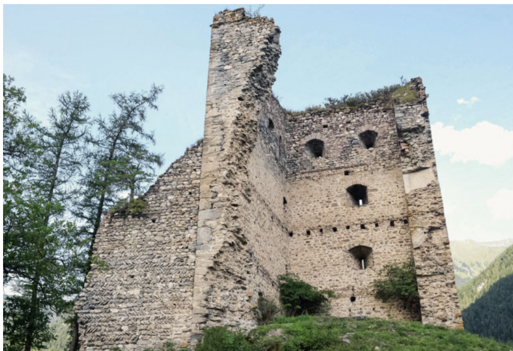
2: Alt Süns, Paspels GR. Die Burg wurde in der Schamserfehde 1451 zerstört und anschliessend grösstenteils abgetragen. Das heute noch hoch aufragende Mauerwerk des damals gebrochenen Turms ist mit Ausnahme der obersten Steinlagen noch in einem ausgezeichneten Zustand. Aufnahme von Südwesten.
