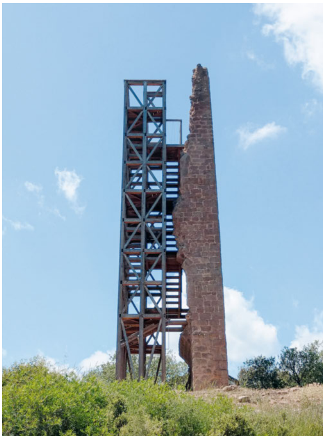
7: Stabilisierung durch Gerüstkonstruktion, Torre de Merola 2022.
