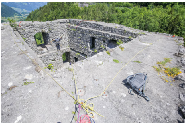
5: Kandergrund BE, Felsenburg. Durch eine Klettergruppe des Schweizerischen Alpenclubs erfolgt eine regelmässige Reinigung der Mauern von Pflanzenbewuchs.
