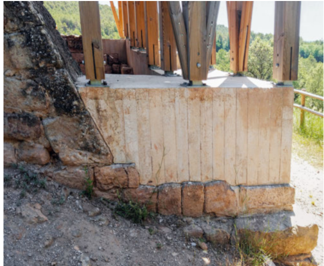
8: Das neue Fundament, Torre de Merola 2022.
