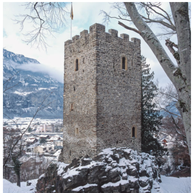
3: Restiturm in Meiringen, Aufnahme von Nordosten (Foto: ADB 2007).
