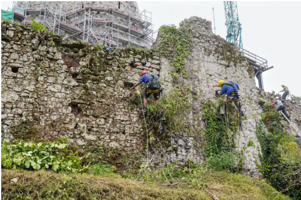
15: Pfeffingen, Pfeffingen BL. Höhenarbeiter befreien einen in den 1930er-Jahren sanierten und stellenweise bereits wieder stark in Mitleidenschaft gezogenen Ringmauerabschnitt vom Efeubewuchs. Die Reinigung erfolgte auf diese Art, weil man den Istzustand des Mauerwerks noch vor dem Aufbau des Baugerüsts orthofotografisch dokumentieren wollte. Aufnahme von Nordosten.
