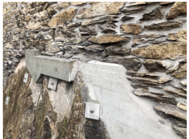
4: Chur, Haldenstein, Burg Haldenstein, Zustand Sockelbereich nach Sanierung.
