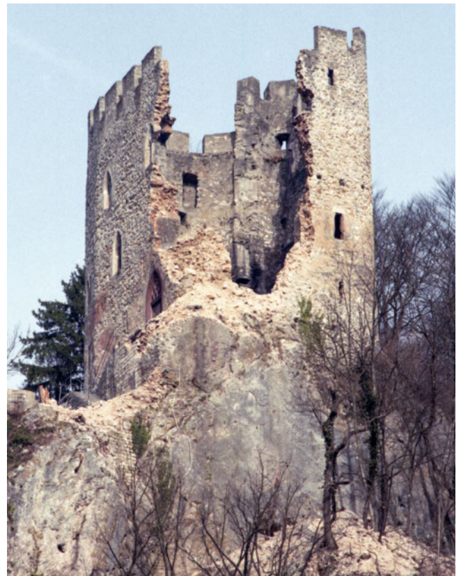
10: Neu-Thierstein, Büsserach SO. Nach dem Teileinsturz am 2. März 1997. Aufnahme von Westen.
