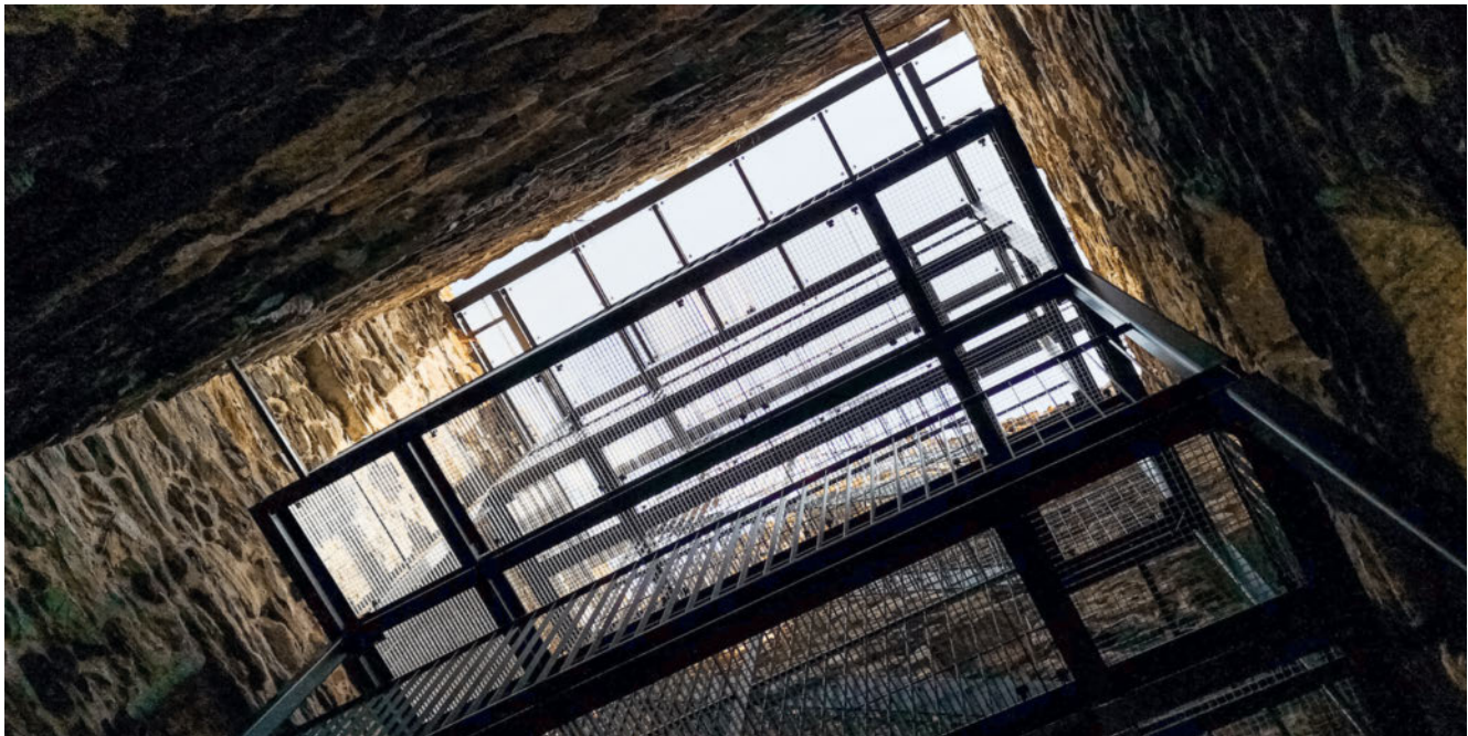
2: Einsicht in die bestehende Treppenturmkonstruktion im Turm von Hospental (Foto: Justizdirektion UR, Abt. Denkmalpflege und Archäologie, Thomas Brunner).
