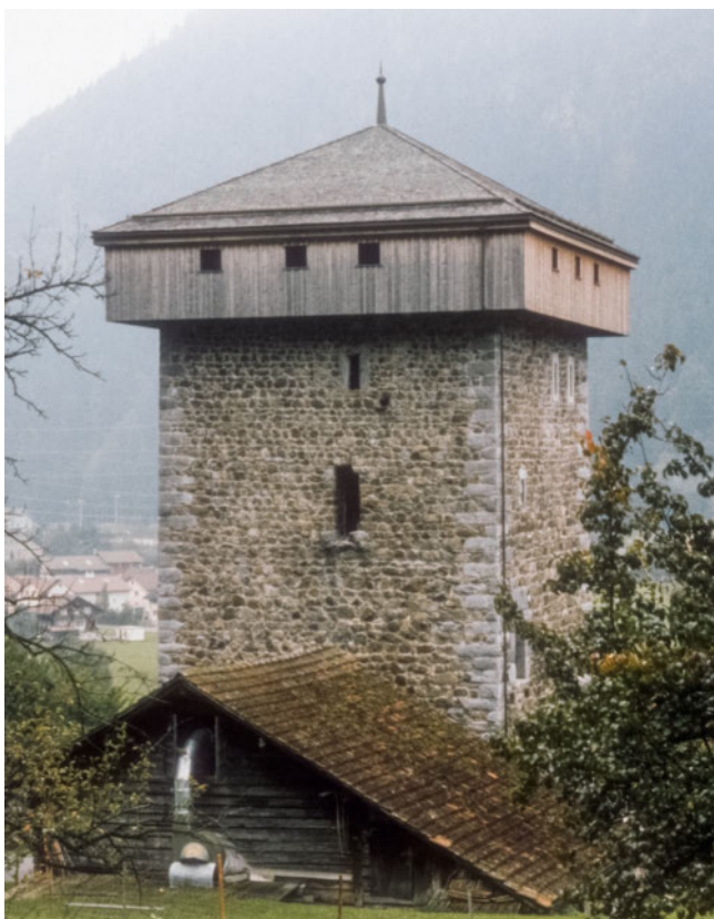
16: Meierturm, Silenen UR. Zustand drei Jahre nach dem Bau des Obergadens im Jahr 1989. Dank dem Dachaufbau verbesserte sich das Klima im Turminnern umgehend und die bis anhin feuchten Mauern trockneten mit der Zeit wie gewünscht aus. Leider hat man die Abmachung, den Turm nicht zu nutzen, bereits 2002 gebrochen, indem man im Innern eine öffentlich zugängliche Treppe zum Obergaden einbaute. Aufnahme von Nordosten.
