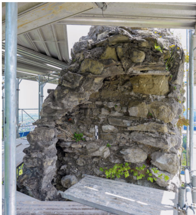
19: Mauer M3. Offen liegender, in deutlich erkennbaren Lagen eingebrachter Mauerkern, von Südwesten. Die 1936 aufgeführte Vormauerung zum Schutz des damals offen liegenden Mauerkerns ist grossflächig weggebrochen.
