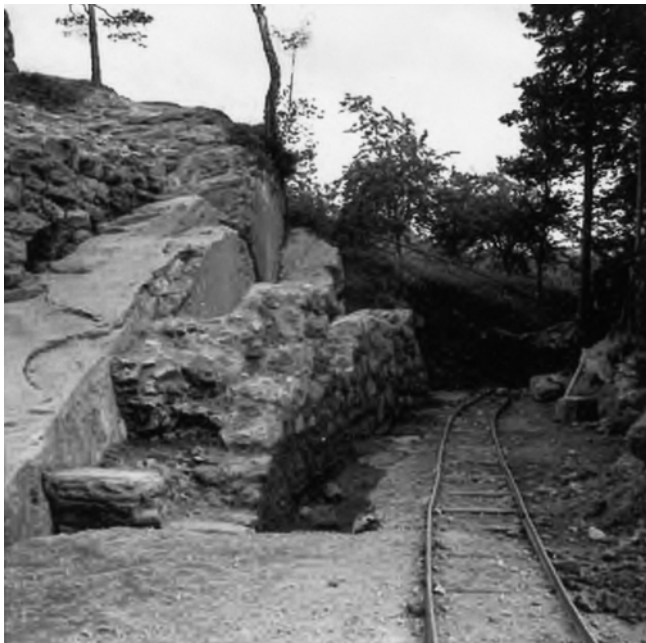
38a/b: Aushubarbeiten im Graben entlang der Mauer M17 im Jahr 1937, von Norden. Das anfallende Aushubmaterial wurde mit Loren über eine dafür verlegte Rollbahn abgeführt und damit wohl der heute vorhandene Platz entlang der Nordseite der Burganlage aufgeschüttet.
