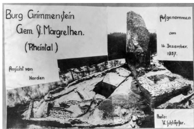
42: Aus mehreren Bildern zusammengesetzte Panoramafotografie von Walter Schläpfer, datiert 16. Dezember 1937, von Norden. Zu erkennen ist der fertig konservierte Turm. Die östlich anschliessenden Mauerzüge inkl. Zisterne sind zu diesem Zeitpunkt erst vollständig freigelegt.
