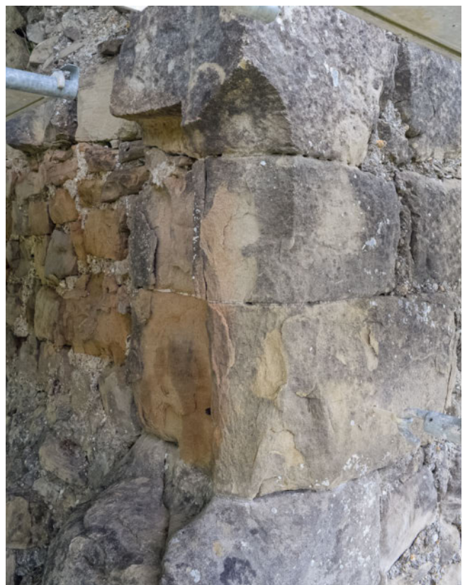
27: Mauer M3, Fenster M3.1, von Südwesten. Der zur Hälfte erhaltene Rest des äusseren rundbogigen Gewändes.
