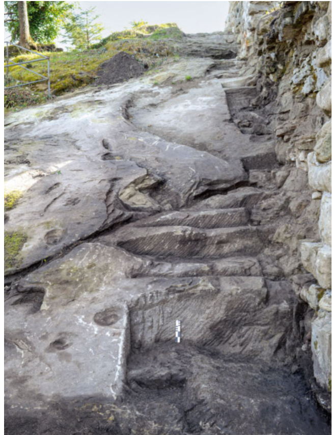
30: Treppenartig ausgehauene Fundamentabsätze vor der Aussenfassade der Mauer M2, von Norden. Für die Funktion der überbreiten und deutlich unterschiedlich hohen Stufen im unteren Abschnitt gibt es keine naheliegende Erklärung.
