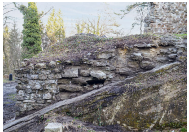
28: Mauer M4, Aussenfassade, von Westen. Die Turmecke M4/M1 wurde 1936 neu aufgeführt. In der Bildmitte ist der noch teilweise wieder zugemauerte Zugang zum «Raubgräberloch» zu erkennen.
