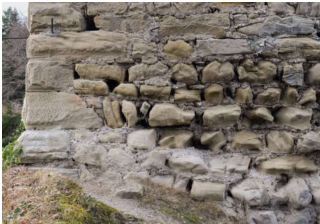
16: Mauer M2, Aussenfassade. Eckpartie M2/M3, von Osten. Das Mauerwerk ist im Sockelbereich stark ausgewaschen. Die Quader aus grauem Sandstein sind bedeutend weniger verwittert als die beige. Auf der Oberfläche der Bosse des drittuntersten Ecksteins sind die beim Abbau des Quaders entstandenen halbkreisförmigen Schrämmspuren noch gut erhalten.
