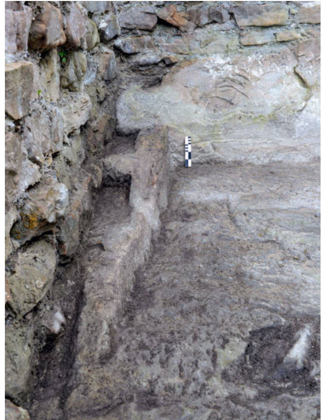
32: Felsarbeiten in der inneren Turmecke M2/M3, von Norden. Am Fuss der Mauer M2 sind vorkragende Fundamentabsätze erkennbar, daneben die in einem zweiten Arbeitsgang abgesenkte Felsoberfläche, um einen einiger-massen horizontalen Fussboden zu schaffen.
