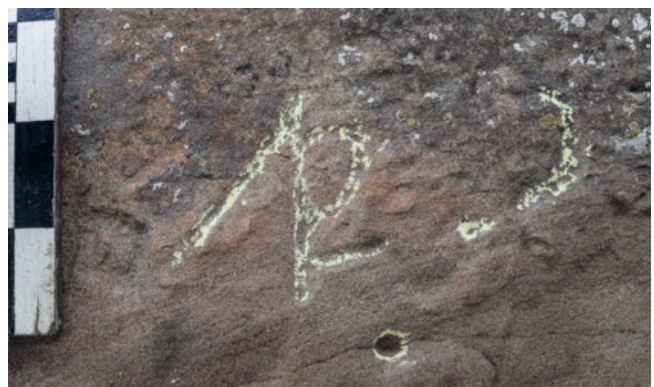
23: Mauer M2. Steinmetzzeichen 7.4, eingehauen in den drittuntersten Sandsteinquader des Eckverbandes M2.2, mit Kreide nachgezeichnet, von Norden. Das unterhalb des Zeichens zu erkennende kreisförmige Loch ist vermutlich der Rest eines verwitterten Zangenlochs.
