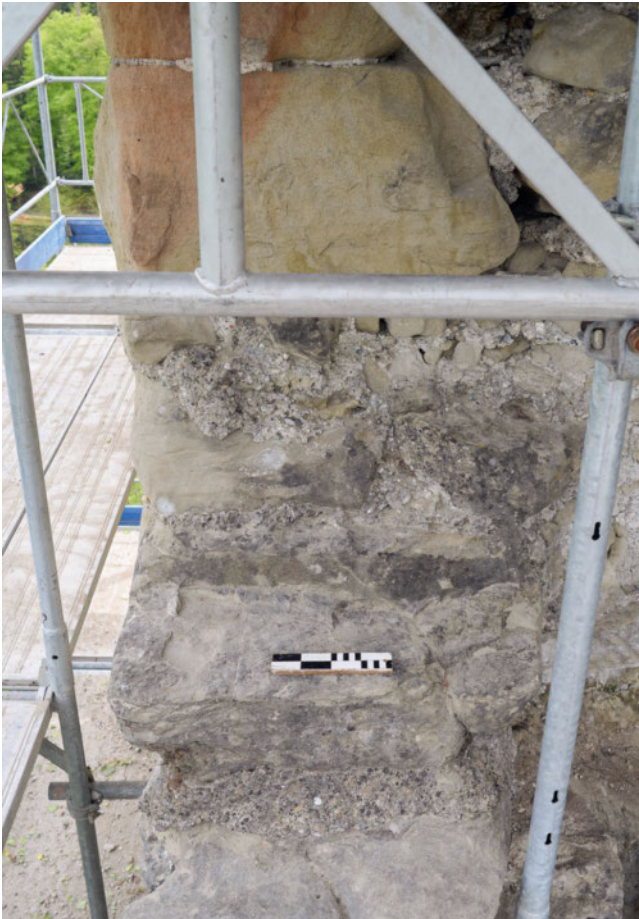
24: Mauer M2. Balkenlager 2.4, von Norden. Das in die Oberfläche eines Quaders eingehauene Balkenlager ist vermutlich der letzte erhalten gebliebene Rest eines Balkenkanals für einen gegen Osten auskragenden Balken. Oberhalb davon ist die Basis des stark brandgeröteten Eckverbandes M2.2 zu erkennen.
