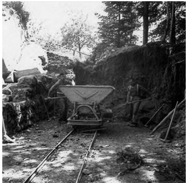
38a/b: Aushubarbeiten im Graben entlang der Mauer M17 im Jahr 1937, von Norden. Das anfallende Aushubmaterial wurde mit Loren über eine dafür verlegte Rollbahn abgeführt und damit wohl der heute vorhandene Platz entlang der Nordseite der Burganlage aufgeschüttet.
