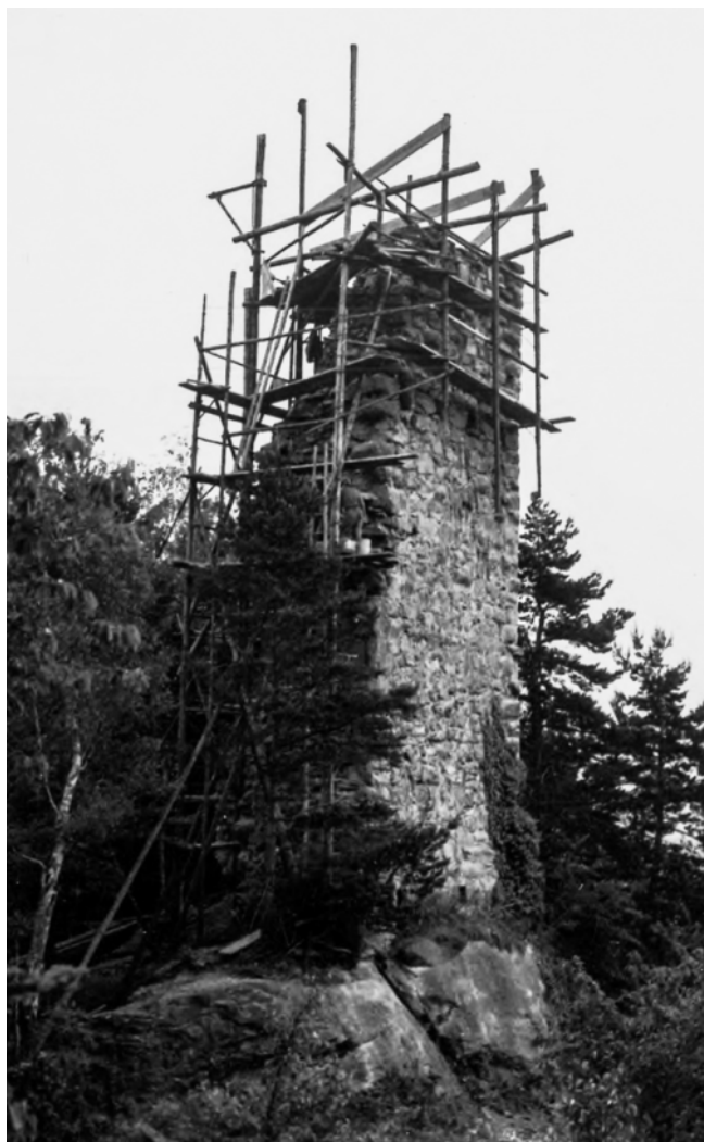
41: Stangengerüst, welches man 1936 zur Sanierung des «Eckzahns» gebaut hat, von Südwesten. Beachtenswert ist das «hängende Gerüst» im Kronenbereich der Südfassade.
