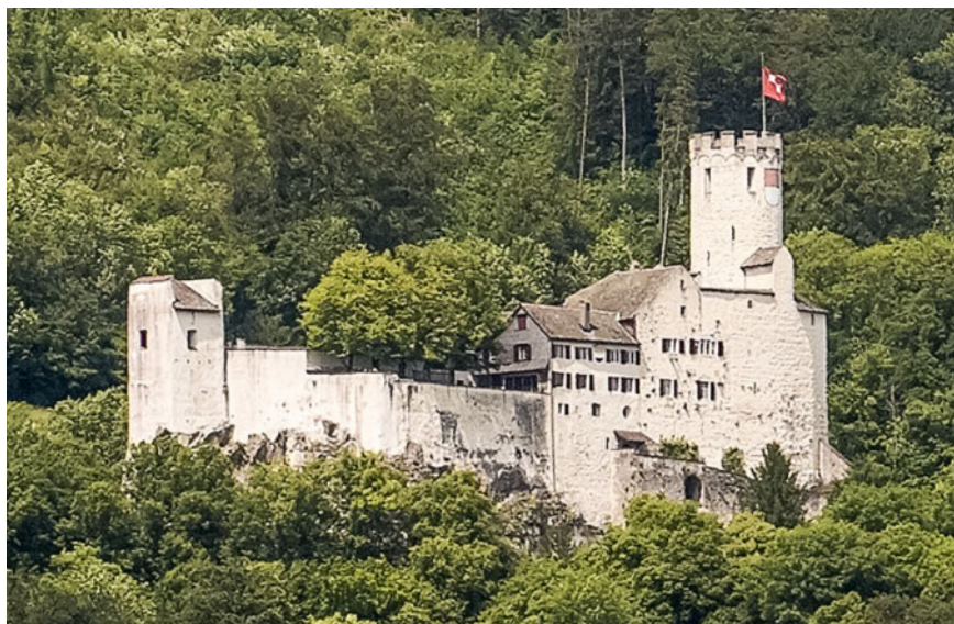
Neu-Bechburg (Foto www.oensingen.ch ).
