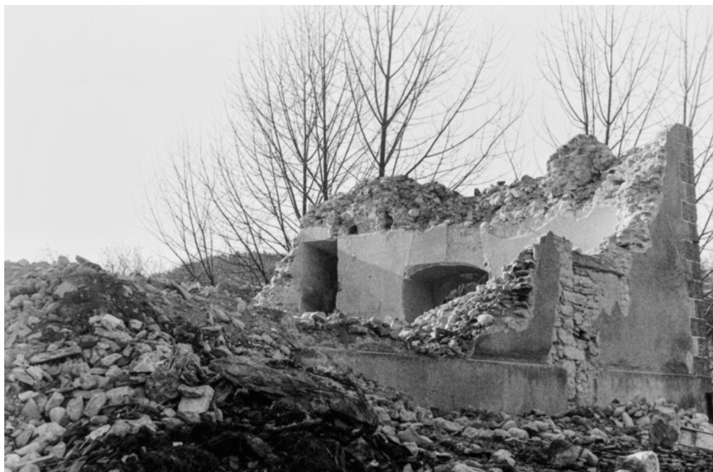
2: Abbruch der Kirche Lengnau AG.
