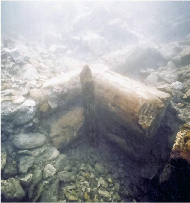
36: Stansstad NW, Wasserturm. Blockbaufundament verfüllt mit Steinen, März 1977.
