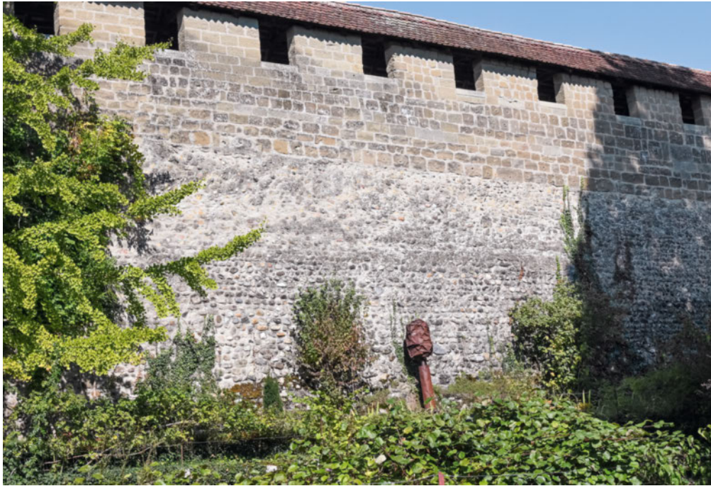
3: Eine Mauer erzählt Geschichten: Blick auf die Stadtmauer von Murten, die wohl auf die Mitte des 13. Jh. zurückgeht und nach dem Stadtbrand von 1416 ihr heutiges Aussehen erhielt (Peter Niederhäuser 2025).
