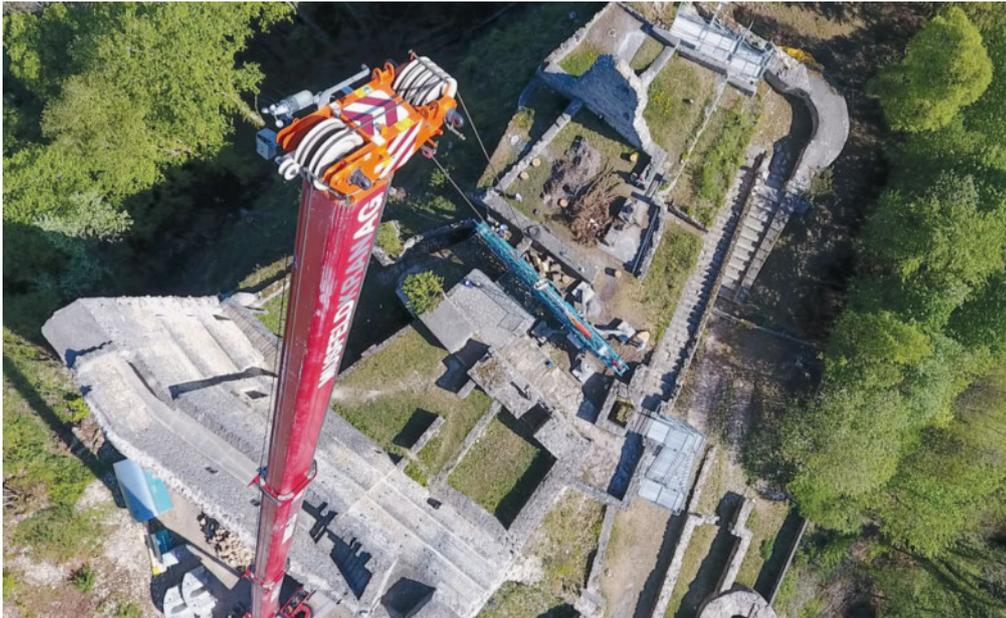
25: Präzisionsarbeit: Ein Pnekran hebt den in Teile zerlegten Baukran über die Schildmauer, wo er im Oberen Burghof zusammengesetzt und dann aufgestellt wurde.
