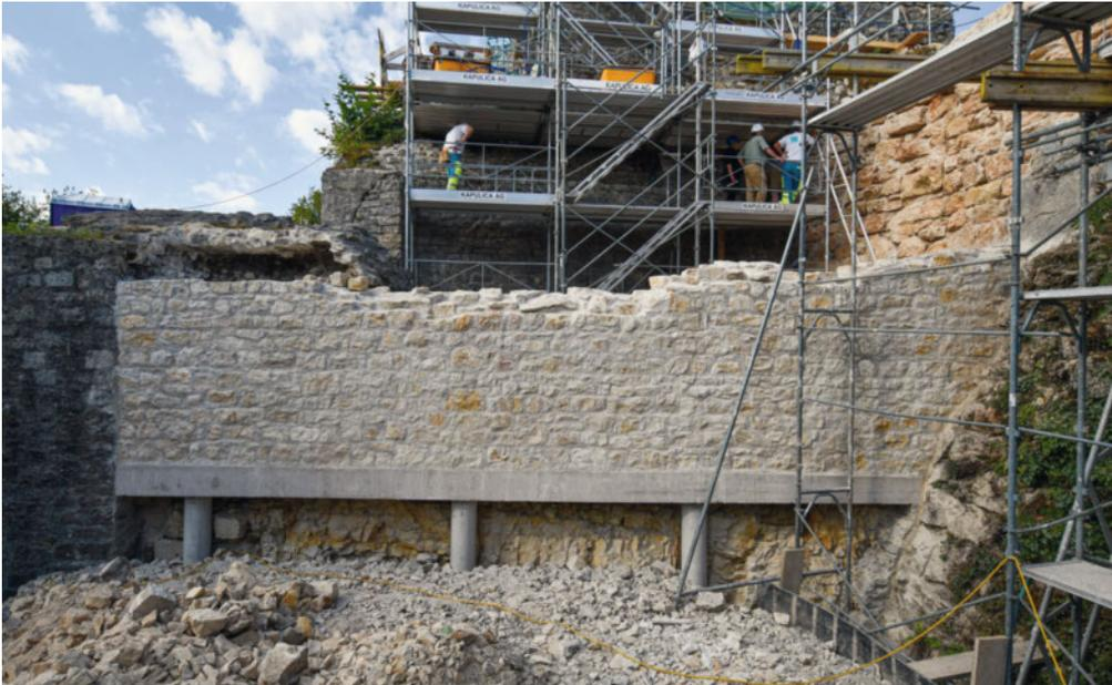
30: Eine innovative Sanierungsmassnahme an der neu erstellten Abschlussmauer des Brunnenhauses: Die neue Mauer steht auf einem Betonriegel über Betonstützen – eine Hilfskonstruktion, die danach mit Schutt angebösch wurde, um künftig den dahinterliegenden Fels frei entwässern zu können.
