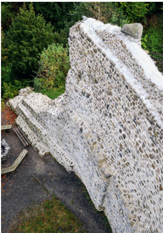
10: Häggenschwil SG, Ruine Alt Ramschwag. Sockelmauern M3 und M2 (v.l.n.r) und Mauer M4 am Ende der Schildmauer. Die Verstärkung der Mauer M1 im Mauerabschnitt SM2 und der Absatz am inneren Fuss der 1. Aufstockung SM3.2 der Schildmauer sind deutlich zu erkennen. Der Mauerabsatz auf der Rückseite der 2. Aufstockung (Schildmauerabschnitt SM4) ist auf den vollständigen Verlust des inneren Mauermantels zurückzuführen. Aufnahme 2024, von Süden.
