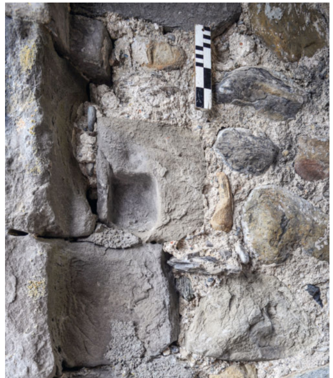
34: Häggenschwil SG, Ruine Alt Ramschwag. Turm. Hochengang 9.2, Sandsteinquader in der linken Leibung mit Raste für den Schiebebalken. Aufnahme 2022, von Nordosten.
