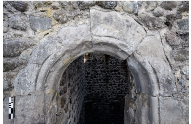
33: Häggenschwil SG, Ruine Alt Ramschwag. Turm. Hochengang 9.2, Aussenansicht. Aus vier Werkstücken zusammengesetzter Rundbogen. Die Oberfläche des linken Scheitelsteins ist fast vollständig zerstört. Seine Unterseite wurde zusammen mit einem Teil des links daran ansetzenden Steins um 1930 mit Zementmörtel nachprofiliert. Aufnahme 2022, von Südwesten.
