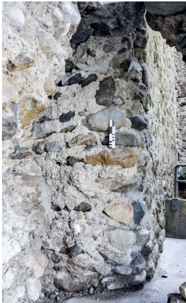
9: Häggenschwil SG, Ruine Alt Ramschwag. Turm: Bresche 11.1 und Abbruch des Schildmauerabschnitts SM1. Aufnahme 2022, von Nordosten. Oben: Grundrisskizze der Befunde in der Bresche 11.1.
