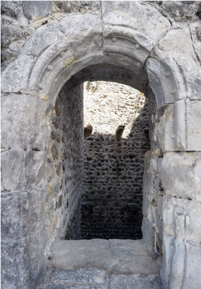
32: Häggenschwil SG, Ruine Alt Ramschwag. Turm. Hochengang 9.2, Aussenansicht. Das vermutlich in Zweitverwendung eingesetzte Gewände ist aus 12 unterschiedlich gut erhaltenen, profiliert behauenen und teilweise mit Rosetten verzierten Sandsteinquadern zusammengesetzt. Aufnahme 2022, von Südwesten.
