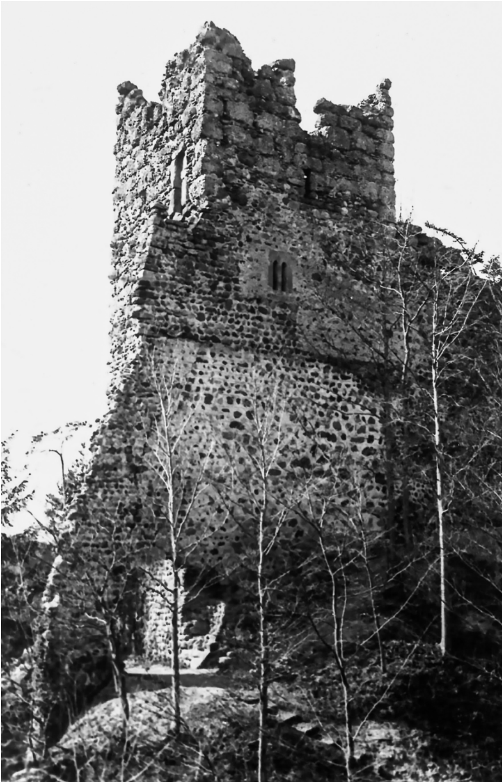
13: Häggenschwil SG, Ruine Alt Ramschwag. Turm und südwestlicher Teil der Schildmauer. Das Gewände des Tors ist ausgebrochen. An der Fassade der 1. Aufstockung SM3.1 der Schildmauer haftet ein grosser Putzleck. Das schräg abgemauerte Ende des Mauerabschnittes SM1 ist am oberen noch ca. 3 m hoch erhalten. In der Südwestfassade des Turms sind der Austritt 9.5 und die untersten noch erhaltenen Gewändesteine der Öffnung 9.6 im 4. Obergeschoss zu erkennen. Aufnahme um 1900, von Südosten.
