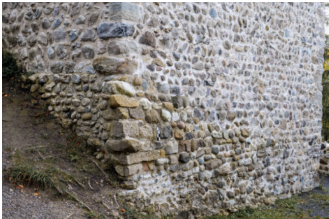
20: Häggenschwil SG, Ruine Alt Ramschwag. Turm. Die Mauerpartie M5.1 hebt sich in der Ecke M10/M1 und in der Fassade der Mauer M10 deutlich ab. Sie scheint um 1930 als Ersatz des damals ausgewitterten Mantels der Mauer M6 des Vorgängerbaus VG1 eingesetzt worden zu sein. Aufnahme 2024, von Norden.
