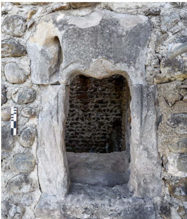
37: Häggenschwil SG, Ruine Alt Ramschwag. Turm. Bifore 9.3, Aussenansicht. Gewände aus grauem, oberflächlich leicht brandgerötetem Sandstein. Monolithischer Sturzstein mit zwei Rundbögen an der Unterseite. Der Mittelpfosten fehlt. Aufnahme 2022, von Südwesten.
