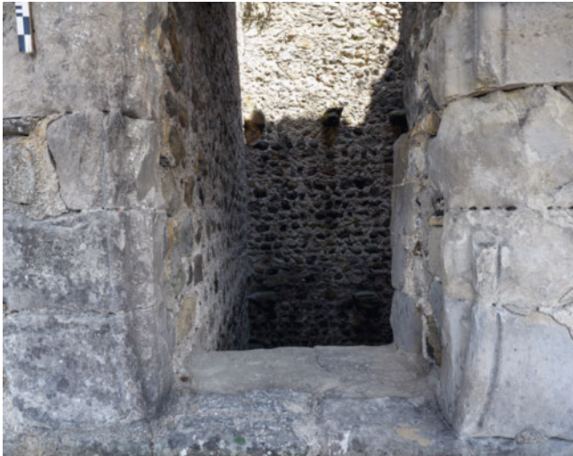
35: Häggenschwil SG, Ruine Alt Ramschwag. Turm. Hocheingang 9.2, Leibungen des äusseren Gewändes. Beachtenswert ist, dass die Profilierung der Gewändesteine ohne Sockel direkt auf der Schwelle ansetzt. Aufnahme 2022, von Südwesten.
