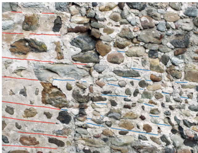
11: Häggenschwil SG, Ruine Alt Ramschwag. Mittlerer Abschnitt der Fuge 1.16 in der Aussenfassade der Schildmauer. Deutlich zu erkennen ist, dass die mit Fugenstrichen versehenen Rasa-Pietra-Putze auf den Schildmauerabschnitten SM1 (rot markiert) und SM2 (blau markiert) nacheinander aufgetragen worden sind. Drohnenaufnahme 2016, von Südosten.
