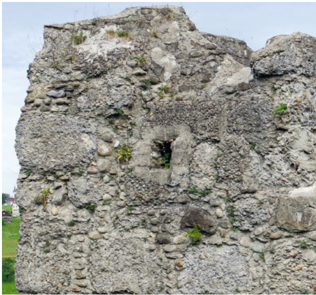
49: Häggenschwil SG, Ruine Alt Ramschwag. Turm. Öffnung 12.2, Aussenansicht. Das quadratische Gewände ist in eine grössere Öffnung eingebaut, deren ursprünglicher Verwendungszweck unbekannt ist. Die um 1930 mit Zementmörtel eingefasste Öffnung diente vermutlich als Flugloch eines dahinterliegenden Nistkastens für Raubvögel. Bei den in der Fassade sichtbaren Einschlüssen aus kleinen Kieselsteinen handelt es sich mehrheitlich um damalige Flickstellen. Aufnahme 2016, von Südwesten.
