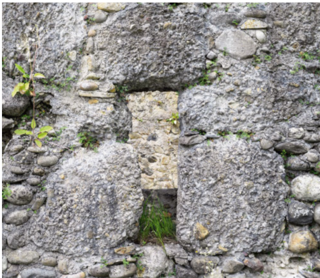
45: Häggenschwil SG, Ruine Alt Ramschwag. Hochrechteckiges Schartenfenster 11.2, äusseres Gewände, ausschliesslich aus Nagelfluhquadern zusammengesetzt. Aufnahme 2022, von Nordosten.
