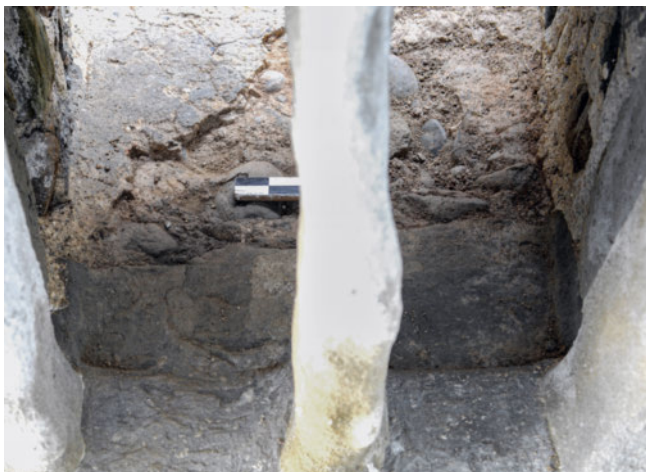
40: Häggenschwil SG, Ruine Alt Ramschwag. Turm. Bifore 1.2, Fensterbank. Die Qualität und Farbe des Sandsteins unterscheiden sich vom Rest des Gewände. Der in die Bank eingehauene Sims passt in seinen Abmessungen nicht zum Gewände. Im Hintergrund sind noch Reste des auf der Fensterbank aufgetragenen Mörtelglattstrichs zu sehen. Aufnahme 2022, von Südosten.
