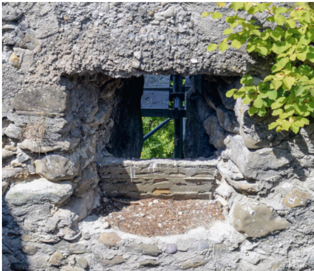
44: Häggenschwil SG, Ruine Alt Ramschwag. Turm. Hochrechteckiges Schartenfenster 10.1, Innenansicht. Das gesamte innere Fenstergewände inkl. Sturz in Nagelfluhimitat wurde um 1930er rekonstruiert. Gleichzeitig hat man auch die Quermauer (8.7) als Nisthilfe für Greifvögel eingebaut. Aufnahme 2022, von Südosten.
