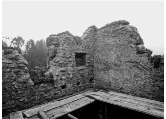
24: Häggenschwil SG, Ruine Alt Ramschwag. Turm. Frisch saniertes Mauerwerk in der Ecke M12/M9 mit den Öffnungen 12.3, 12.2 und 9.6 (v.l.n.r.). Die drei in der Mauer M12 vorhandenen Balkenlöcher sind Überbleibsel der Fussbodenkonstruktion des 4. Obergeschosses. Beachtenswert sind die Rasenziegel, die man um 1930 auf den Mauerkronen auflegte. Aufnahme um 1930, von Norden.
