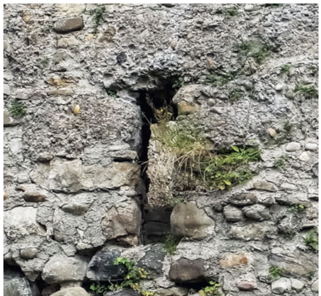
46: Häggenschwil SG, Ruine Alt Ramschwag. Turm. Hochrechteckiges Schartenfenster 12.1, äusseres Gewände aus unterschiedlichen Steinmaterialien zusammengesetzt. Aufnahme 2016, von Südosten.
