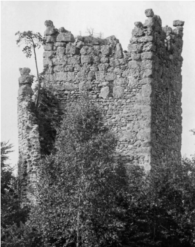
47: Häggenschwil SG, Ruine Alt Ramschwag. Aufnahme von Schildmauer und Turm um 1900. Auf der Schildmauer sind noch Reste der 2. Aufstockung SM4 aus Nagelfluhquadern vorhanden. In der Mauer M11 des Turms sind das Scharfenfenster 11.2 im 3. Obergeschoss und die Öffnungen 11.3 und 11.4 im 4. Obergeschoss zu erkennen. Aufnahme um 1900, von Nordosten.
