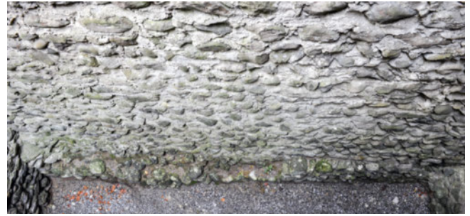
19: Häggenschwil SG, Ruine Alt Ramschwag. Blick von oben auf die in der Art eines Vorfundamentes vorspringende Abbruchkronen des inneren Mauermantels der Mauer M6 des 1. Vorgängerbaus VG1. Links krägt die Mauer noch deutlich um ca. 0,4 m vor, während sie auf der rechten Seite beinahe auf null ausläuft. Aufnahme 2024, von Südosten.
