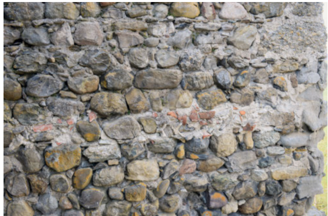
25: Häggenschwil SG, Ruine Alt Ramschwag. Mit Klosterziegeln durchsetzte Mörtelbraue 6.2 in der Aussenfassade der Mauer M11 des Turms. Vermutlich diente sie zur Abdichtung einer Fuge zwischen der rauen Mauer Oberfläche und einem an den Turm angelehnten Dach. Aufnahme 2022, von Osten.
