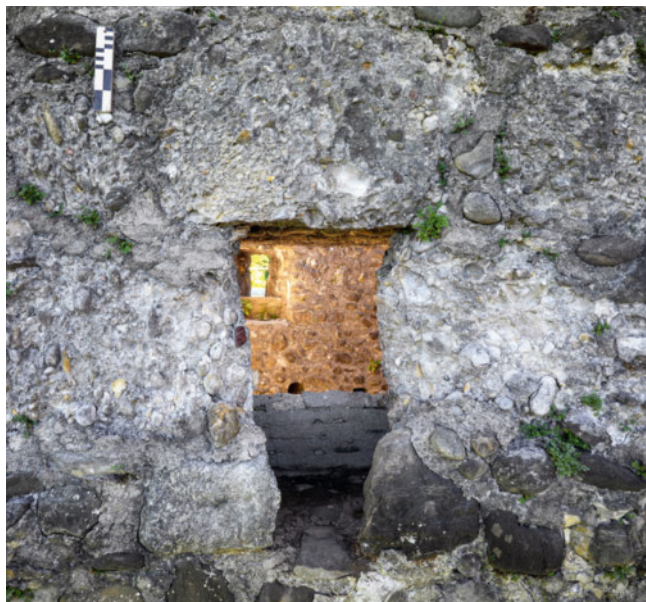
42: Häggenschwil SG, Ruine Alt Ramschwag. Turm. Hochrechteckiges Schartenfenster 9.4, Aussenansicht. Oberflächlich sind die wetterseitig exponierten Gewändesteine in den Leibungen, mit Ausnahme des Urgesteins links unten, stark abgewittert. Aufnahme 2022, von Norden. Aufnahme 2022, von Südwesten.
