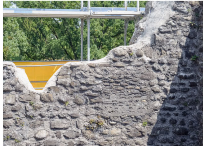
48: Häggenschwil SG, Ruine Alt Ramschwag. Turm. Öffnung 11.3, in der Innenfassade der Mauer M11, um 1930 zugemauert. Aufnahme 2022, von Südwesten.
