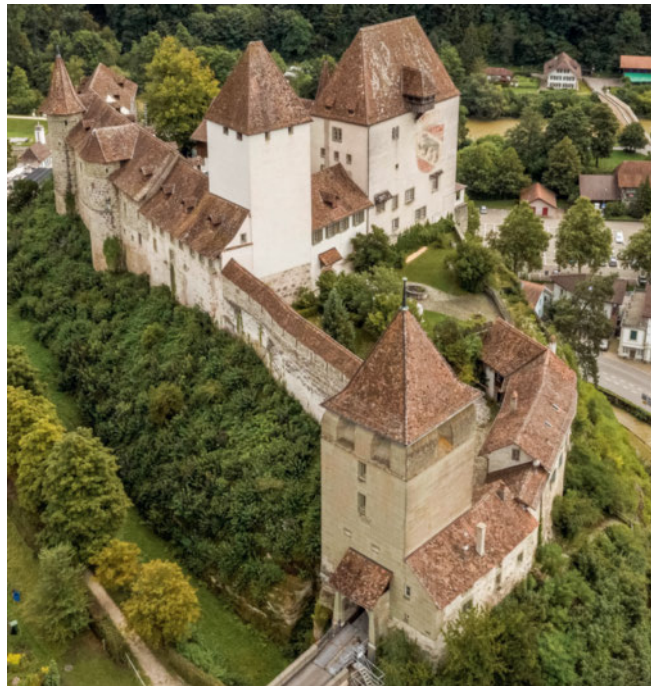
10: Die Vorburg West von Schloss Burgdorf 2019 mit Torturm und Anbau von 1559 auf dem Sockel eines mittelalterlichen Vorgängergebäudes. Blick nach Südosten.
