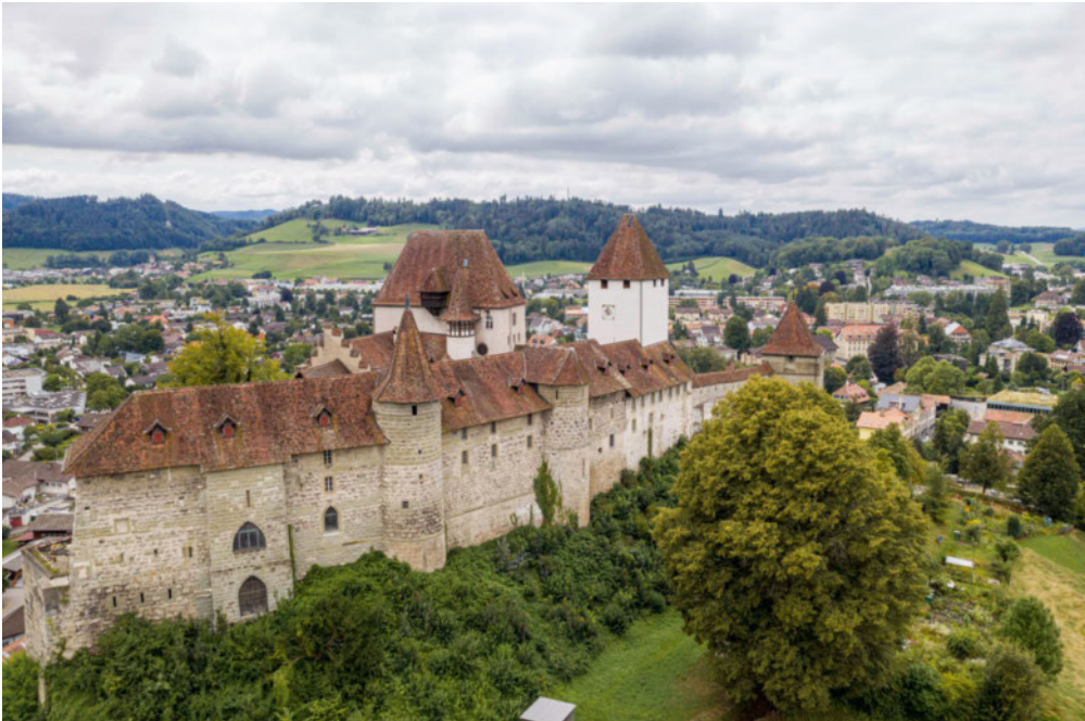
9: Nordfront des Schlosses Burgdorf 2019, im Vordergrund der später gekappte kyburgische Torturm und links davon die Reste des dreigeschossigen Gebäudes aus der kyburgischen Bauphase. Blick nach Südwesten.
