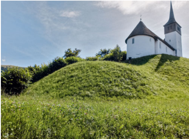
6: Weil Alt-Rapperswil oberhalb Altenburg (SZ) bereits 1350 von den Zürichern zerstört wurde, erhielten die Überreste nie die Bezeichnung Schloss . Sie blieb stets eine Burg oder eine Burgstelle.
