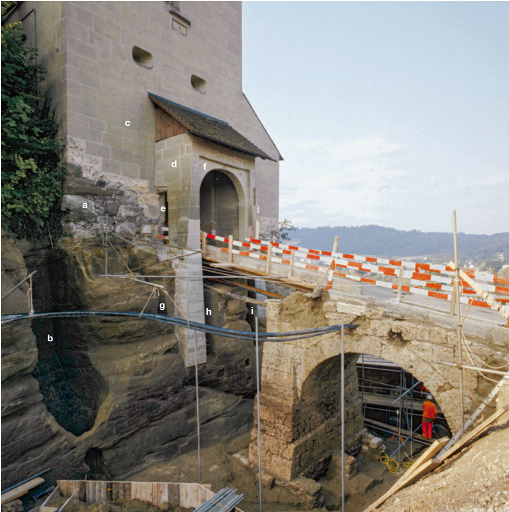
5: Burgdorf, Schloss. Dokumentation während der Sanierung 1982. a älterer Torturm mit Megalithmauerwerk. b Felsgraben zum Tor a. c Torturm von 1560. d Vorwerk von 1587. e Nebenforte ins Vorwerk. f Torblende. g Schwingbalkengrube zu Nebenforte e. h östliche Schwingbalkengrube. i westliche Schwingbalkengrube. Blick nach Südwesten.
