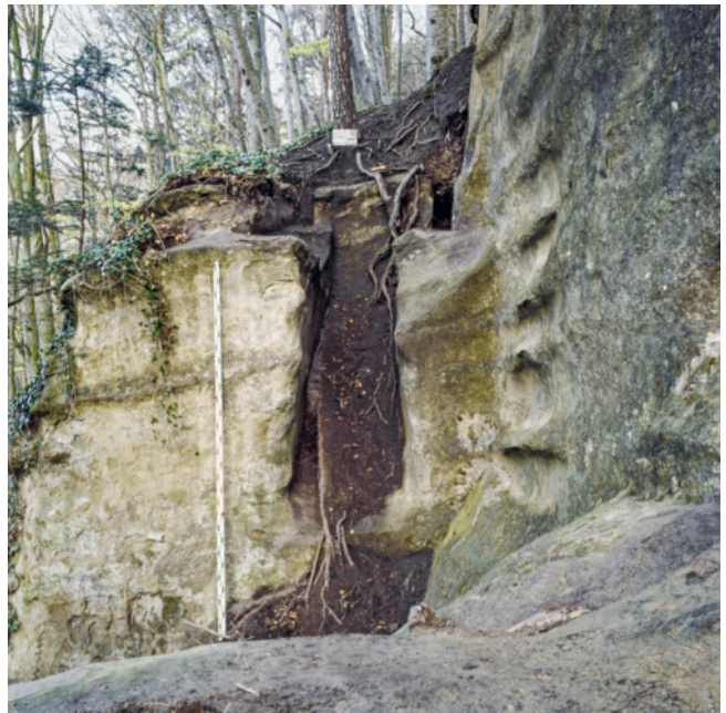
17: Melchnau, Burgruine Langenstein. Blick auf die Schwingbalkengrube und an die Balkengrube für die beiden Konsolbalken im Torweg. Blick nach Westen.
