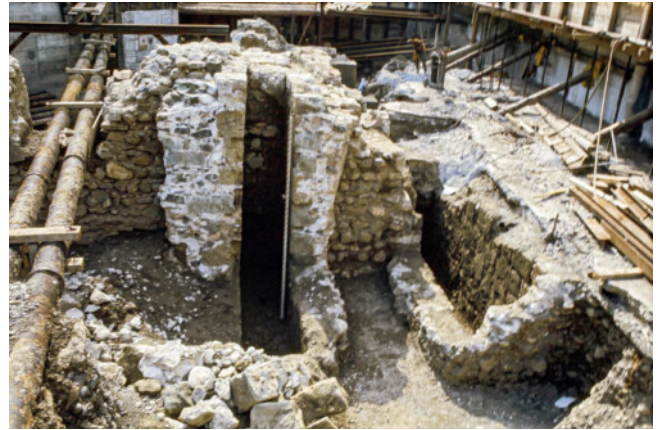
29: Bern, Bahnhofplatz. Archäologische Begleitung des Bahnhofumbaus im Jahr 1971. Vorwerk des Obertors mit den beiden Schwingbalkenschächten. Blick nach Westen.
