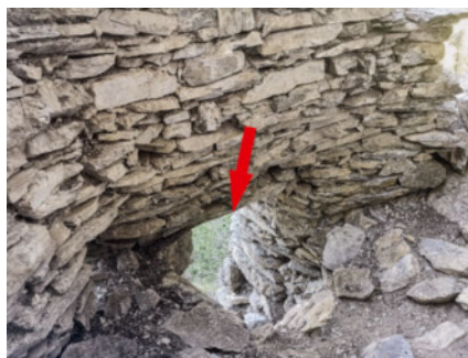
4: Innenaufnahme des Zugangs mit Holzsturz (markiert), darüber kleine Mauervertiefungen, eventuell Balkenlager eines Holzbodens.
