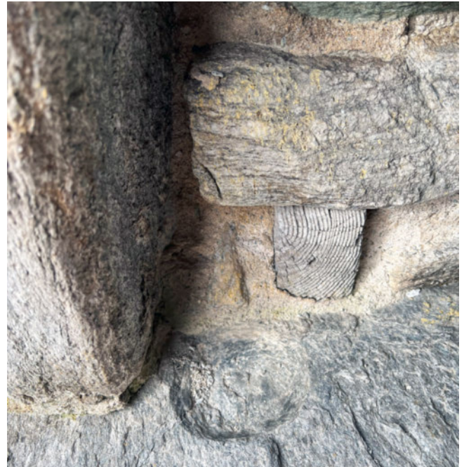
24: Hospental UR, Turm 2021/22. Der Hocheingang mit Befunden für ein Türblatt mit Drehzapfen.
