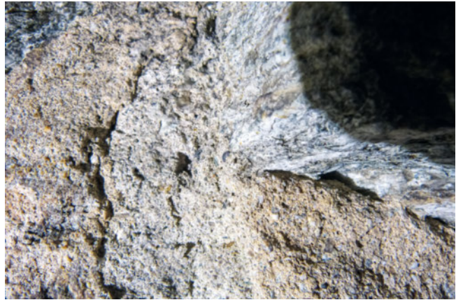
23: Hospental UR, Turm 2021/22. Der bauzeitliche Haufkalkmörtel.
