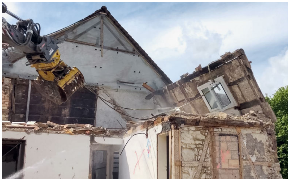
11: Im Mai 2021 wird das Fachwerk von 1472/73 abgebrochen. Hinter der Baggerschaufel ist die Rückseite der Stubenbohlenwand von 1466/67 zu sehen.
