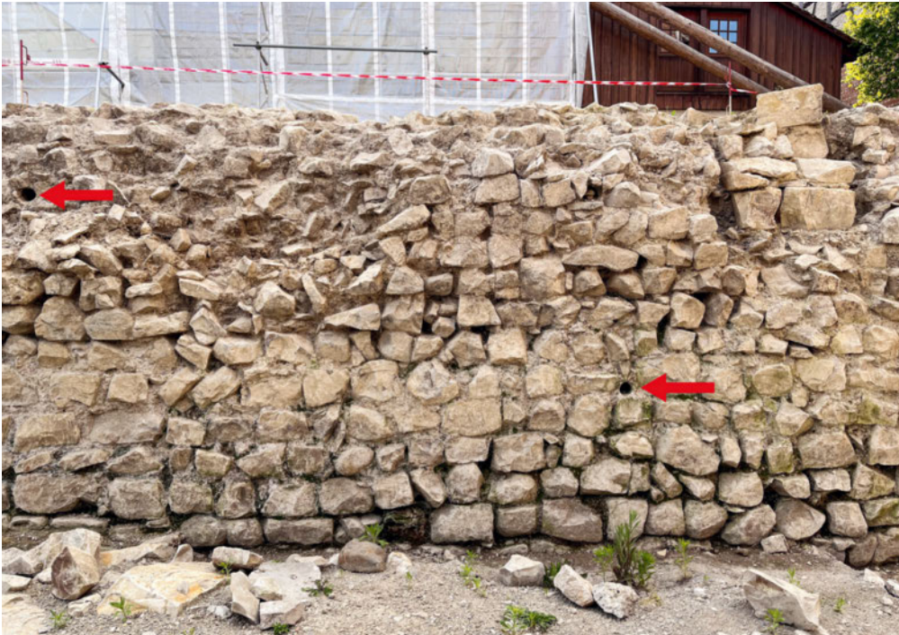
15: Ansicht der östlichen Umfassungsmauer mit Gerüstlöchern (Pfeile) und stärker ausgewaschenem Mörtel in den untersten drei Steinlagen. Die Mauer ist in diesem Abschnitt maximal 2,5 m hoch erhalten. Foto vom Mai 2022.
