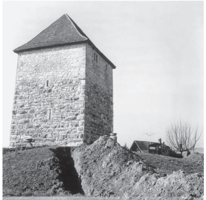
9: Halten, Turm. Ansicht von Westen während den Sondierungen 1966.
