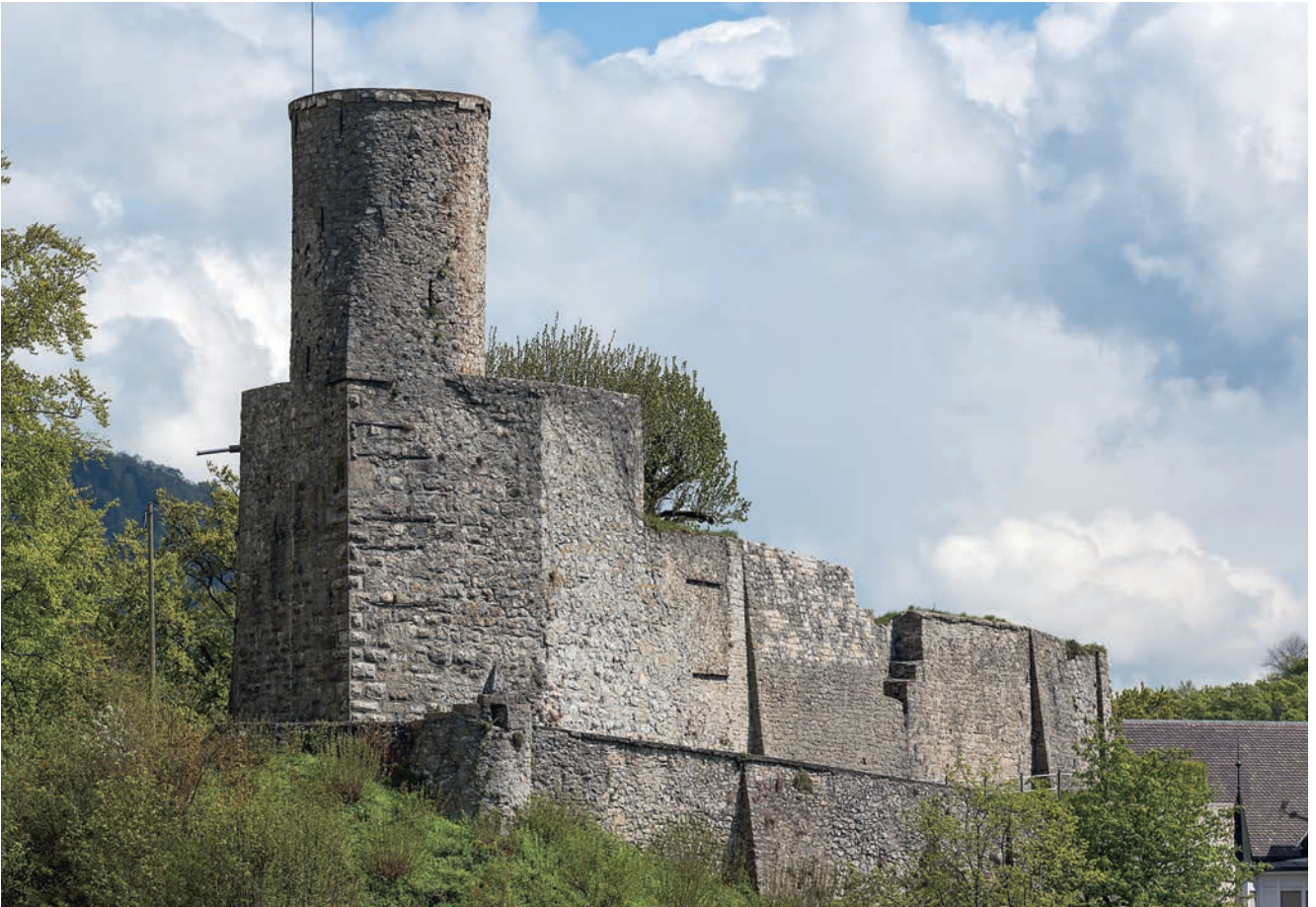
3: Die Burgruine von Westen. Über dem scharfkantigen, mit Bossenquadern ausgezeichneten, schiffsbugartigen Sockel erhebt sich der schlanke Rundturm mit gleitendem Übergang von der scharfen Kante zum vollen Rund.
