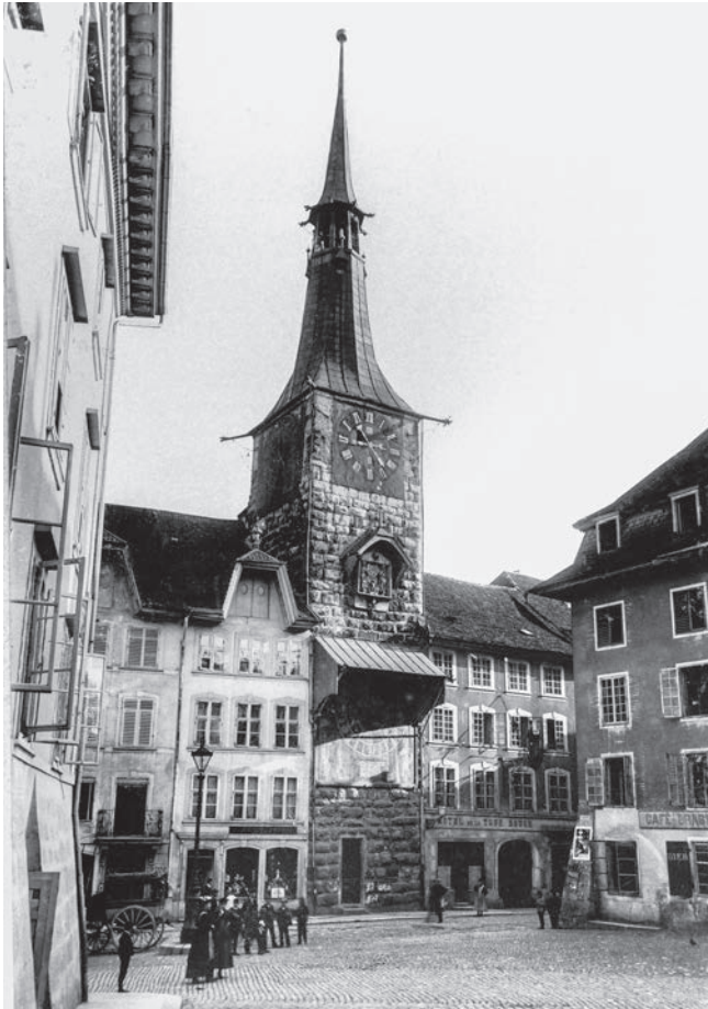
16: Solothurn, Zeitglockenturm (Hauptgasse 44). Ansicht von Norden, 1897.
