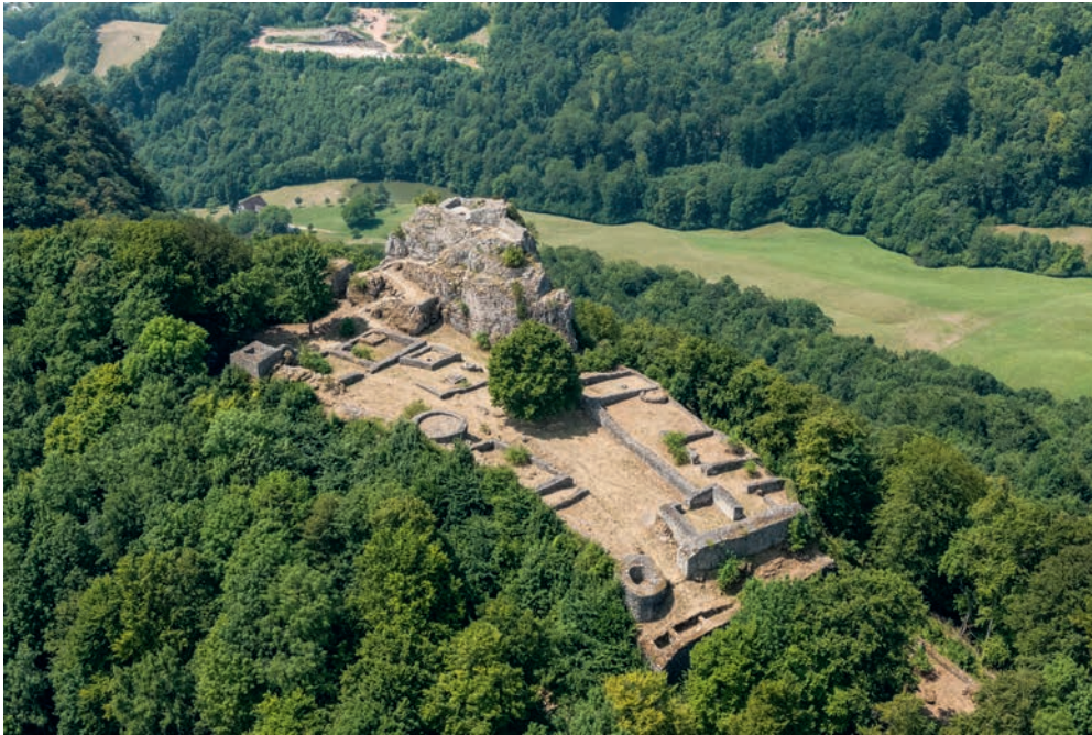
7: Trimbach, Ruine Frohburg. Ansicht von Nordosten, 2015.
