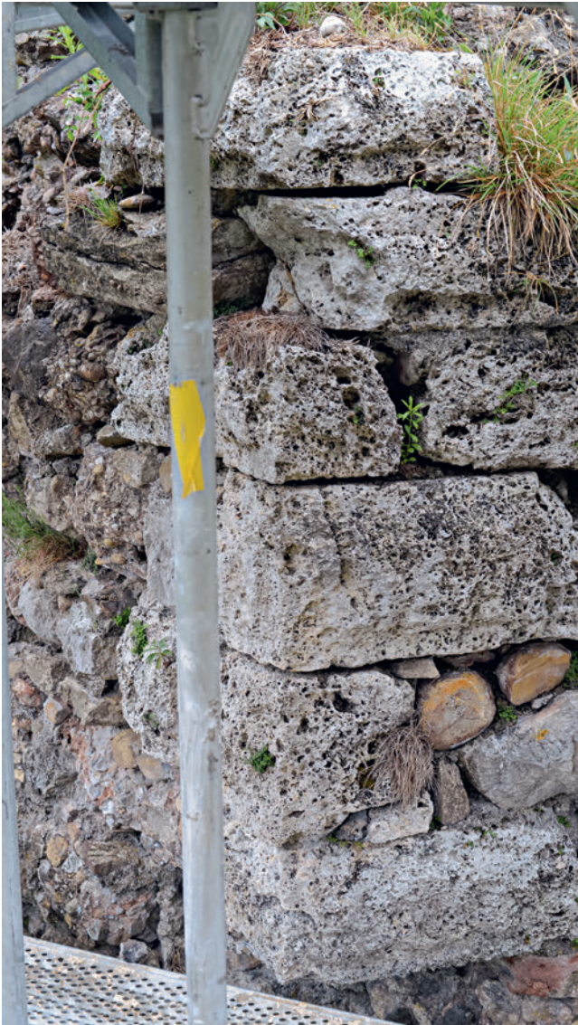
11: Schänis SG, Ruine Niederwindegg, 2020. Ecke M2/M3, Reste des Eckverbandes aus bossierten Tuffsteinquadern, von Osten.
