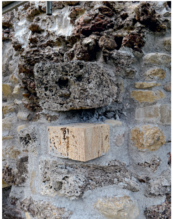
4: Schänis SG, Ruine Niederwindegg, 2020. Ecke M1/M2. Zur Stabilisierung der originalen bossierten Tuffsteinquader eingesetzter Ersatzstein mit glatter Oberfläche, von Norden. Vor dem Schliessen der Lücke wurde zur rückwärtigen Verankerung der Ecke eine Ankerstange aus Chromstahl eingesetzt.
