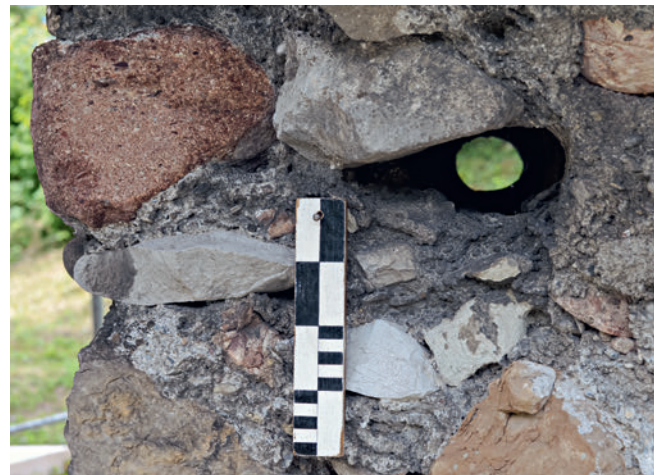
13: Schänis SG, Ruine Niederwindegg, 2020. Mauer M2, Aussenfassade. In seiner Zusammensetzung an Beton erinnernder Mörtel rund um das Gerüsthebelloch 1.3 (aussen), von Nordosten.
