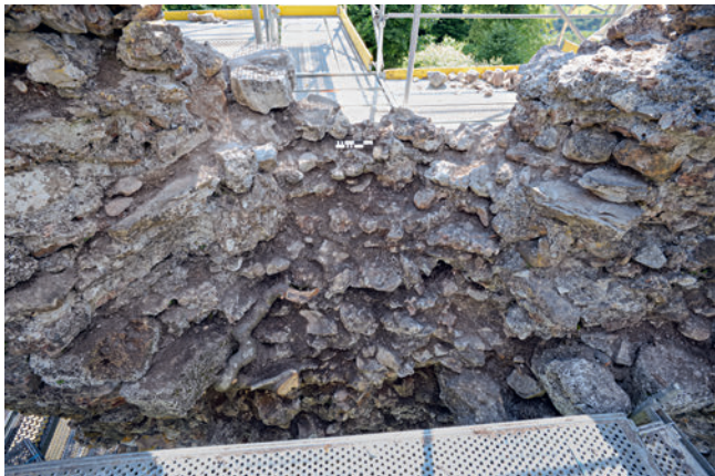
18: Schänis SG, Ruine Niederwindegg, 2020. Mauer M2, Öffnung 4, von Nordosten. Blick in die von Schutt und Bewuchs befreite Öffnung mit den nach aussen laufenden Leibungen und der steil abfallenden Bank. Am untersten, noch vollständig erhaltenen Gewändestein kann die Flucht der Fensterleibung abgelesen werden.
