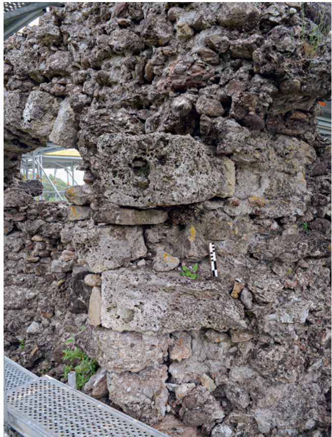
10: Schänis SG, Ruine Niederwindegg, 2020. Ecke M1/M2 mit Resten des Eckverbandes aus bossierten Tuffsteinquadern, von Norden.
