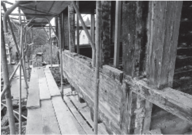
12: Reste der Bohlen-Ständerkonstruktion in der Westfassade 1979, Ansicht nach Norden.
