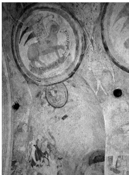
9: Deux vases du temple de Villette, disposés autour d'une fenêtre. – In der Kirche von Villette sind Schalltöpfe auch um die Kirchenfenster eingebaut worden.
