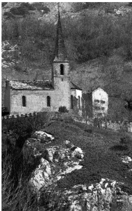
3: Raron, Burghügel. Ansicht von Süden mit Pfarrkirche St. Romanus (entstanden 1508–1517 durch Umbau eines Palas aus dem 14. Jahrhundert) und Wohnturm der Viztume, 12. Jahrhundert.
