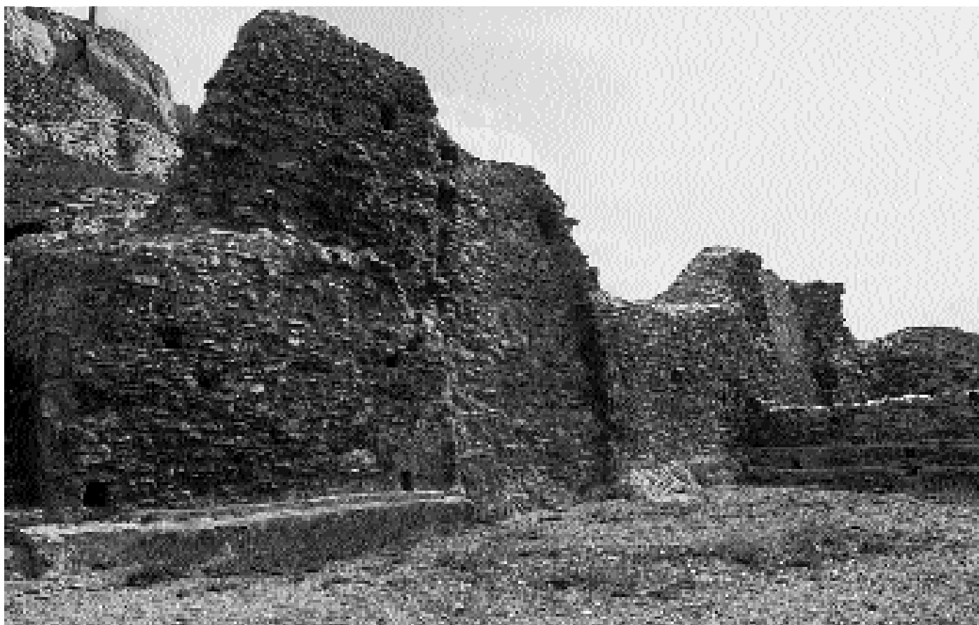
9: Niedergesteln, Ruine der 1384 zerstörten Gestelburg. Blick nach Osten in den Hauptwohnraum des Erdgeschosses. In der Bildmitte Überreste des monumentalen Kamins aus der Bauzeit, eingefasst von später eingebauten Wandbänken.
