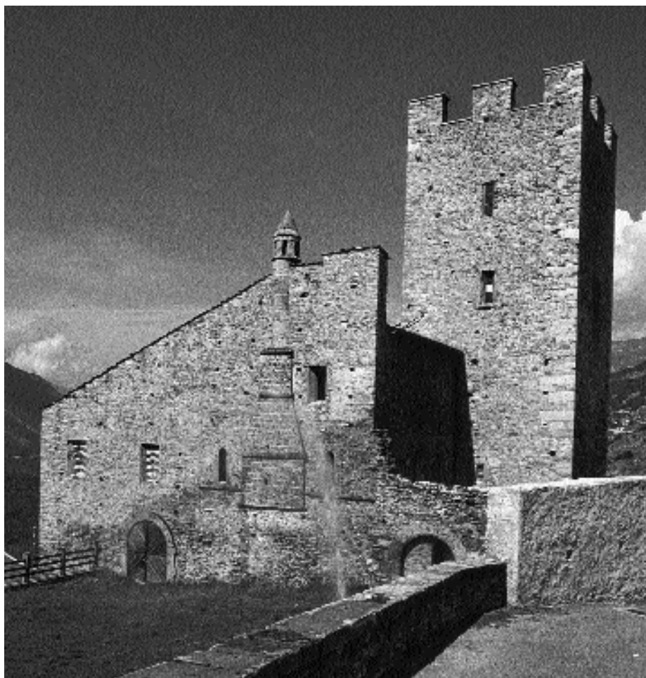
8: Leuk-Stadt, ehemaliges Bischofsschloss. Ansicht von Osten. Der Bau ist z.Z. Gegenstand eines Revitalisierungsprojektes.
