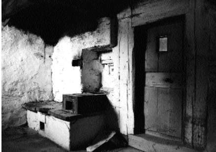
18: Haus Nr. 16: Turmküche in der Turmerneuerung von 1610 mit Herdstelle, wohl des 18. Jhs. und offenem Rauchfang.
