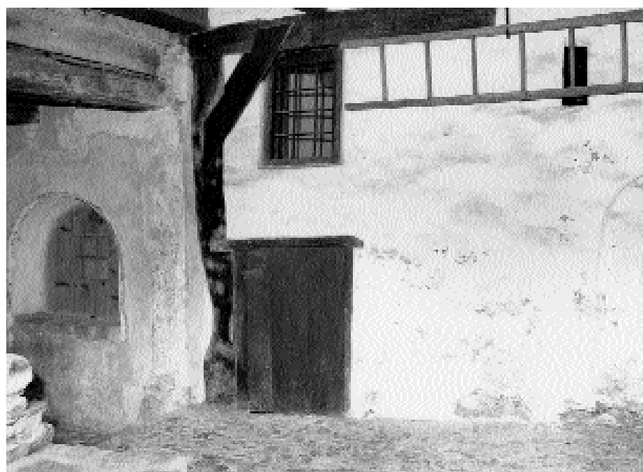
5: Gassenseitiges Fassadendetail des Erdgeschosses von Haus Nr. 7: Reste einer Bohlenständer-Konstruktion der Zeit vor/um 1370 mit späterer Ausmauerung, rechts der einstige Rundbogeneingang im Putz eingeritzt und darüber eine frühe Luzide. Das Laubengebälk ist mit 1370 dendrodatiert.
