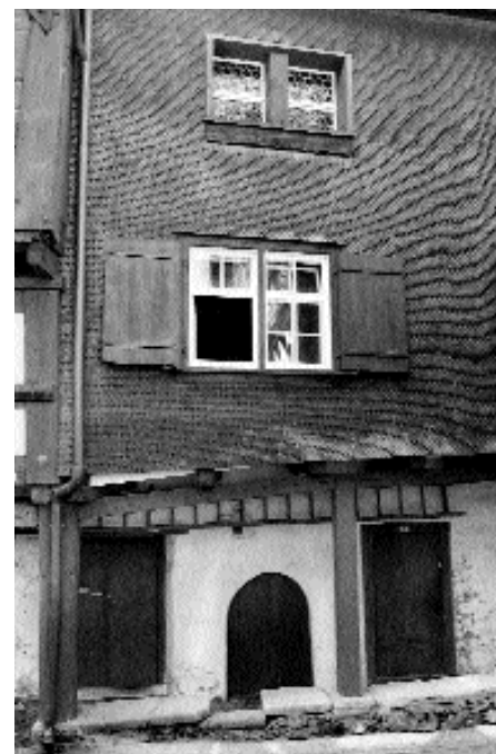
4: Die gassenseitige Fassade der Häuser Nr. 7 links und Nr. 8 rechts zeigt eine architektonisch klar erkennbare Hofstättengrenze. Doch der Augenschein trügt: die drei Türen im Erdgeschoss bedeuten von links nach rechts: Haustür zu Nr. 7, gemeinsamer rundbogiger Kellerzugang zu Nr. 7 und 8, Haustür zu Nr. 8; die Kammer im 1. Obergeschoss gehört zu Nr. 8, jene im 2. Obergeschoss (mit den Butzenfenstern) zu Nr. 7; der Eckständer links zeigt oben eine Blattsasse zu einem nach rechts weisenden Kopfband, das heisst, der Fassadenteil von Nr. 8 war ursprünglich einbeitlich mit Nr. 7 abgebunden und krachte ebenso vor, die heutige Flucht stellt eine spätere Rückversetzung dar.
