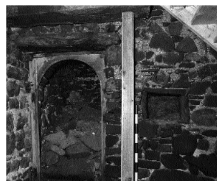
8: Haus Nr. 5/6: Kellertrennwand von um 1265 mit Rundbogentür, Wandnische und darüber einen eingemauerten Kochtopf; links die Stadtmauer.
