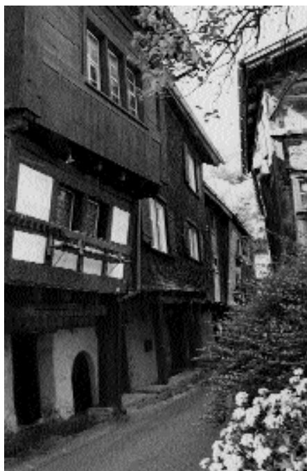
3: Blick von Norden in die «Untere Stadtgasse»; von links kragt Haus Nr. 7 in den Gassenraum.
