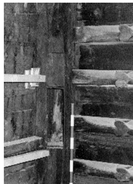
13: Haus Nr. 8, Bohlenständerbau von 1409 d: südlicher Eckständer der grossen Kammer, zierschrägt und mit Nische versehen; rechts die zur Wandausfachung zweitverwendete Stubendecke von 1409 d.
