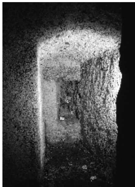
18: Schiessnische im ersten Geschoss des westlichen Zwillingturms (T7) im Zustand 1999.
