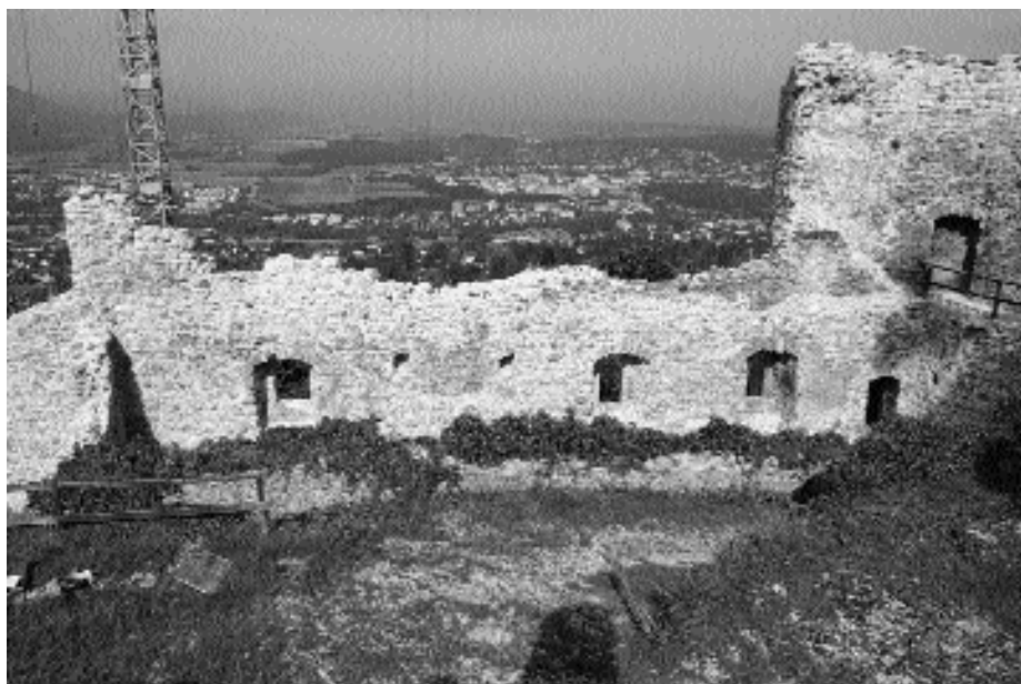
10: Westmauer (M6) des Nordwestbaues von Osten. Übersicht der Innenseite des zweiten und dritten Geschosses im Zustand 1999 nach der Konservierung. Zwischen dem linken und mittleren Fenster die Reste der Kaminanlage.
