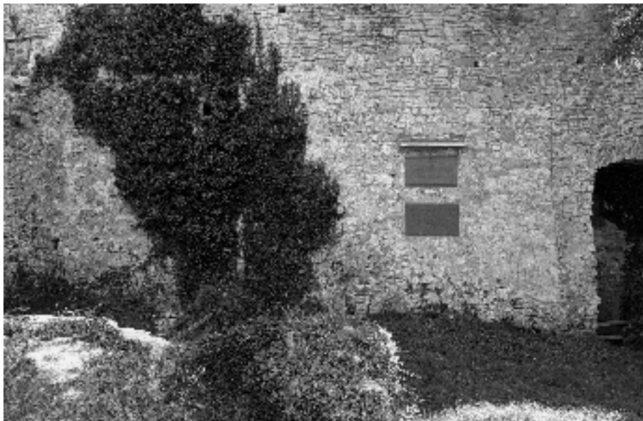
6: Innenseite (M1) des Grossen Bollwerkes von Südwesten im Zustand 1999. Links des Bewuchses ist das grossblockige Mauerwerk (M1a), rechts davon das kleinteilige Mauerwerk (M1b) zu erkennen. Man beachte die horizontal verlaufende Krone und die südöstliche Ecke des kleinteiligen Mauerwerks.
