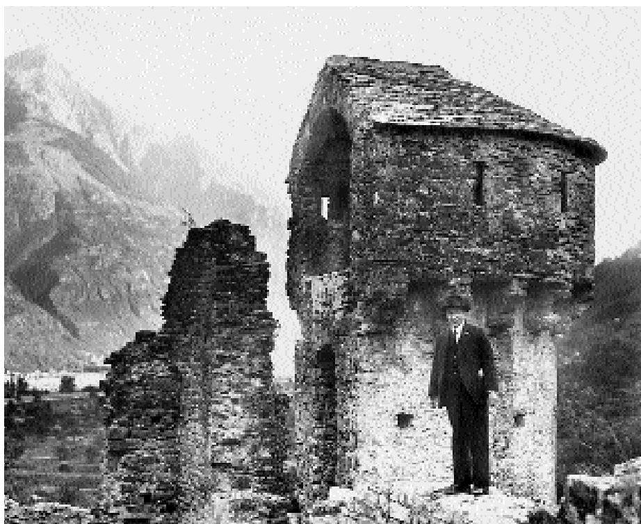
7: Sulla parte superiore della torre semicircolare poggia un parapetto sorretto da beccatelli (mensole), coperto da un tetto in piode a corsi regolari. – Die Webrplattform des Halbrundturmes ruht auf Kragsteinen und ist mit einem Steinplattendach gedeckt (Photo Jean Gabarell, Thalwil).
