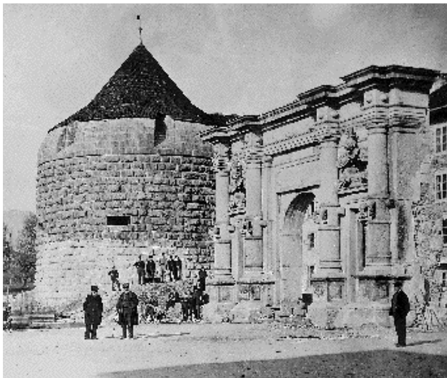
Aufnahme des Äusseren Bieltors kurz vor dem Abbruch im Jahr 1871 (die anschliessenden Schanzenmauern waren zu diesem Zeitpunkt bereits beseitigt). Im Hintergrund Buristurm.
